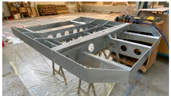
Metallgestell wird in Rumpf eingesetzt: Kiel und Mast werden daran befestigt.
