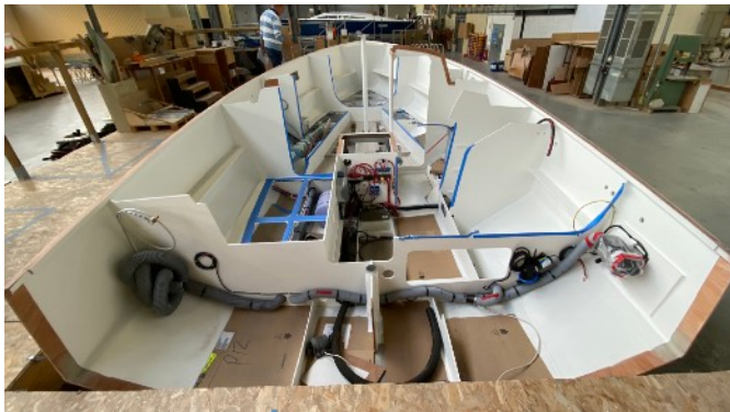
Blick in den Innenausbau: Motor, Leitungen
