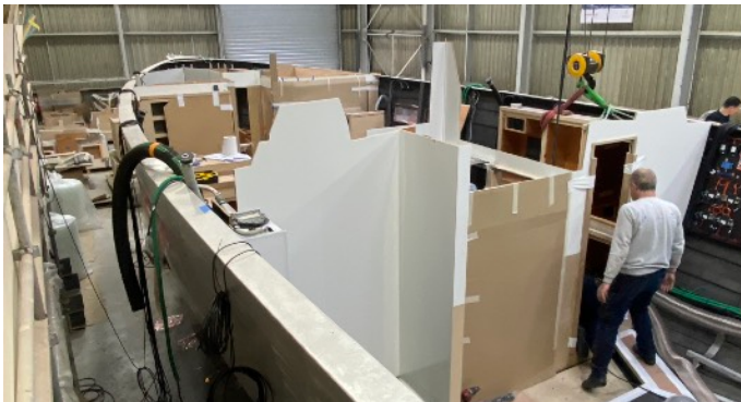
Innenausbau der Allures
