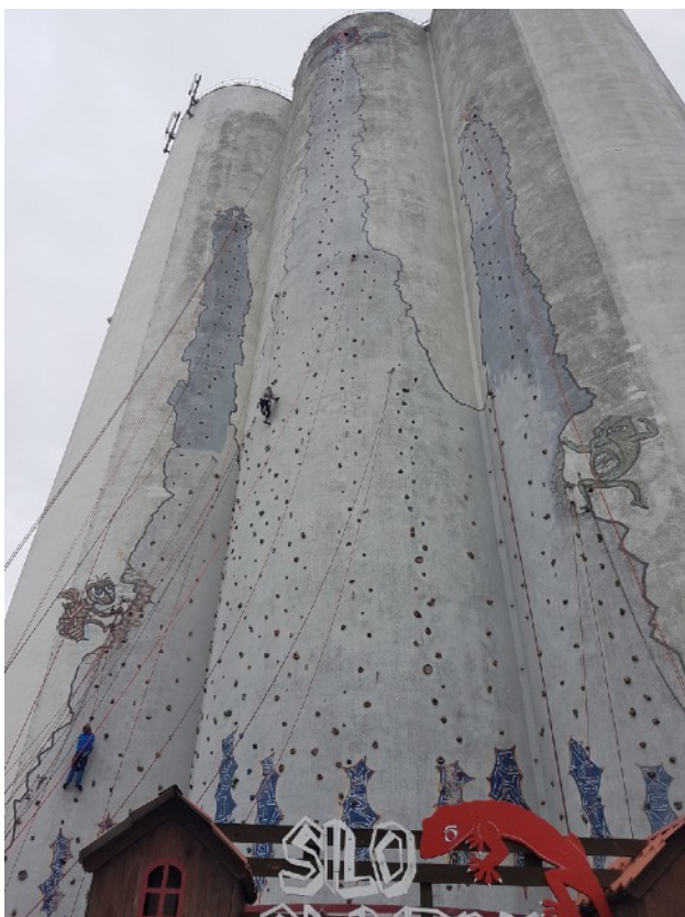
Silo als Kletterwand in Burgstaaken
